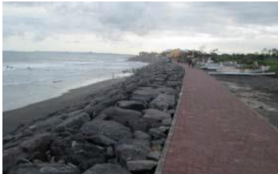
Gambar 3.3 Pembangunan revetment sebagai pencegah erosi
